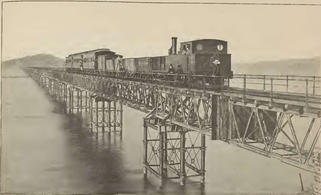
PUENTE SOBRE EL BIOBÍO (CHILE), EL MÁS LARGO DE AMÉRICA, TERMINADO EN 1890
